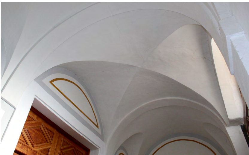
F. 16. Detalle del abovedamiento del pórtico: se observa el tramo central, con la bóveda aristada, y el de la derecha, con una bóveda de cañón con lunetos. Imagen propia.
