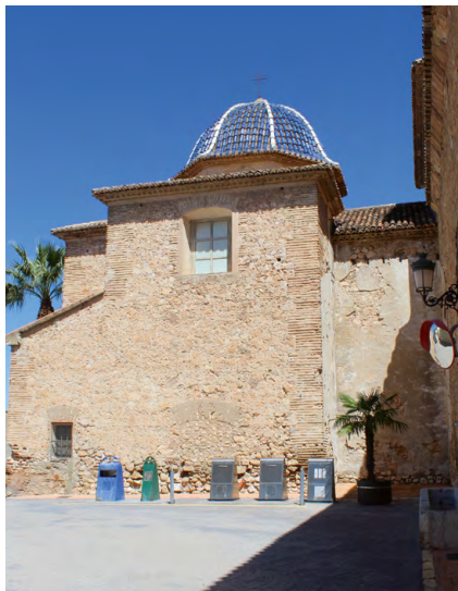
F. 39. Vista exterior de la capilla de la Virgen del Carmen: se aprecia su fábrica y, en especial, la cúpula de tejas vidriadas. Imagen propia.
