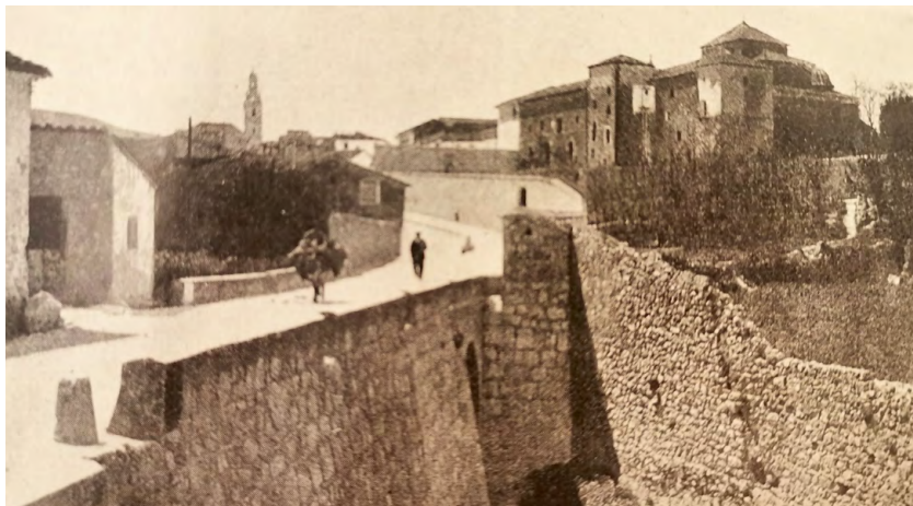
F. 21. Parte trasera, o fachada noreste, de la parte residencial del convento: se aprecia, en primer plano, parte del antiguo huerto, y su tapia; la torre esquinera de la parte residencial, la crujía añadida y, dominando el conjunto, el tejado piramidal de la cúpula. Imagen de Carlos Sarthou Carreres, publicada en SARTHOU CARRERES, Carlos, 1920, p. 349.
