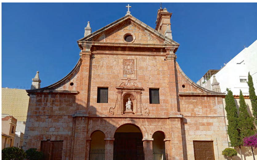
F. 7. Fachada de la iglesia del convento de la Sagrada Familia de Nules. Imagen propia.
