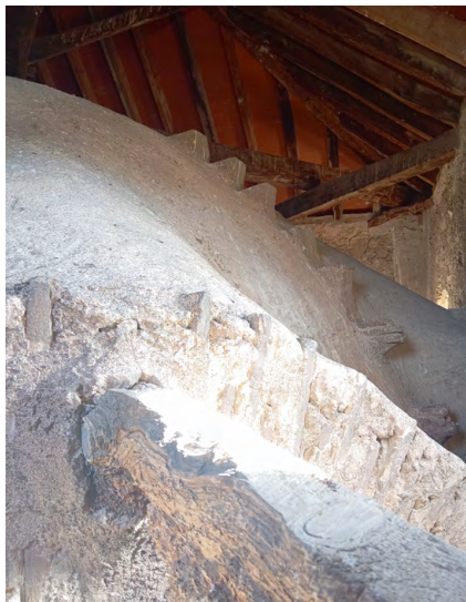
F. 19. El extradós de la cúpula desde el desván que forma su tejado. Imagen propia.
