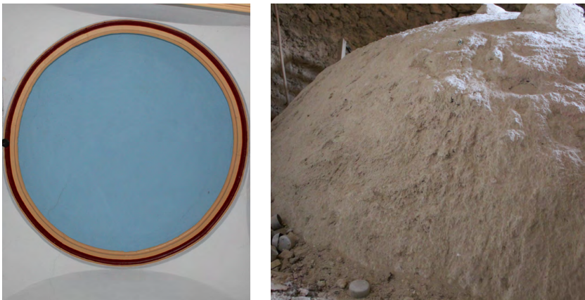
F. 15. Las cúpulas de las capillas laterales. Vista de su intradós desde el interior de la iglesia y de su extradós desde debajo del tejado. Imágenes propias.
