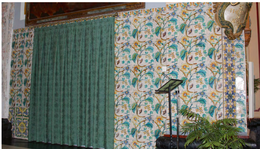
F. 24. Vista del arrimadero cerámico que decora y protege la parte inferior del presbiterio: lado derecho. Cubierto por una cortina, el vano, hoy tabicado, de paso a la sacristía. Imagen propia.
